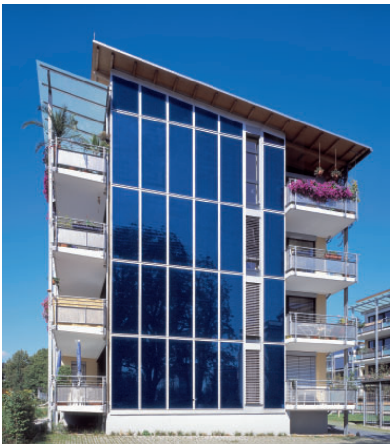
Mehrfamilienhaus mit Fassadenmontage
