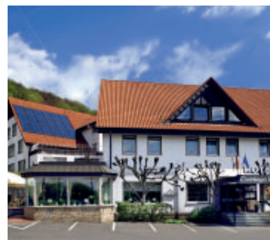
Hotel mit Indachmontage
